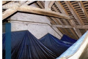
Bâches de protection dans un comble
