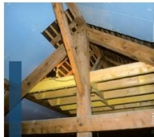
Installation d'un plancher
